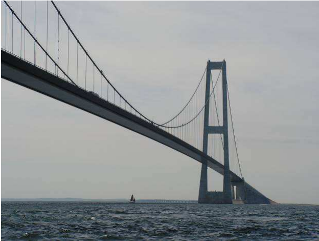
Oben: Die Brücke über den großen Belt ist beeindruckend – Daten für den Ostteil der Brücke: Lichte Durchfahrtshöhe 65 m, Pylone 254 m hoch, Gesamtlänge 6790 m, größte Stützweite 1624 m
